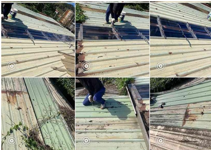
遭吹跑鐵皮修復
