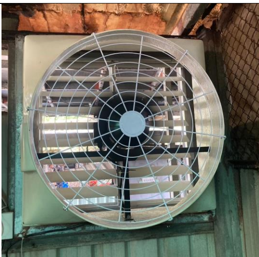
以前損壞無法使用的負壓風扇更新
